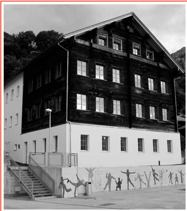
Das frisch sanierte Primarschulhaus in Mund.
