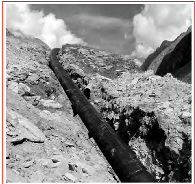
Die neue Druckleitung (Durchmesser 80cm) im Gredetschtal während dem Bau.
