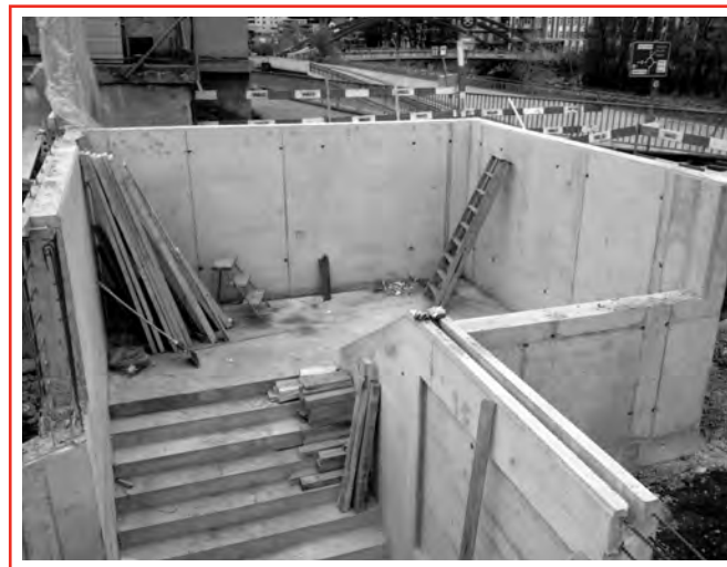
Die neue zweiläufige Treppe auf Seite Naters wird noch vor Weihnachten fertiggestellt.
