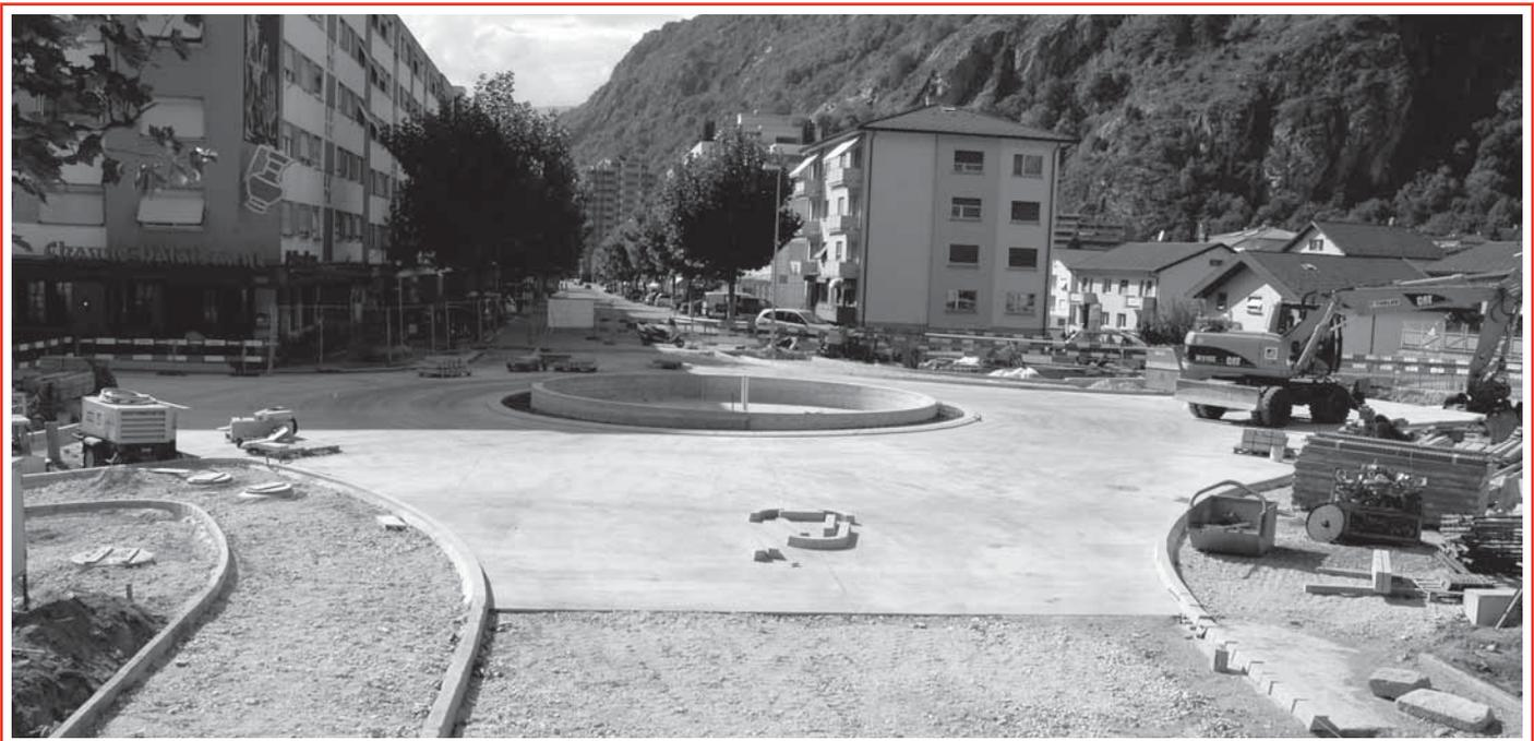
Brücke und Kreisel: fertiger Betonbelag auf der Brückenplatte
