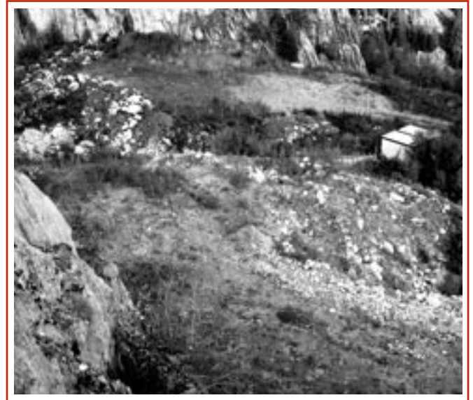
Deponie Blickrichtung Südosten, heutiger Zustand
