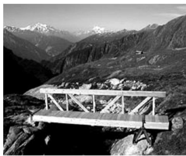
Neue Brücke in Driest
