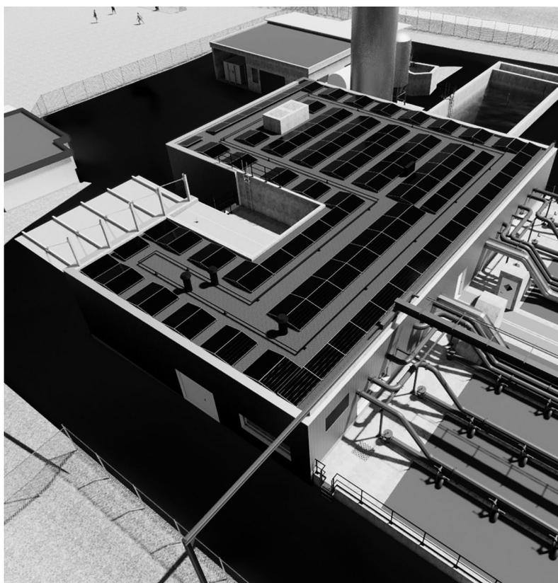
*Der Energiebezug aus dem EW-Netz kann durch ökologischen Strom aus der neuen, auf den Dächern der ARA installierten Photovoltaikanlage reduziert werden.* ©Visualisierung Hunziker Betatech AG
